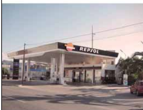
Avda. Cortes Valencianas, 19 46650 CANALS (Valencia) Con centro de lavado para vehículos
