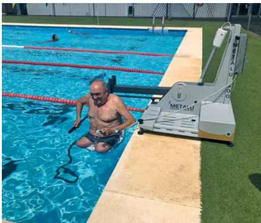
INSTAL·LACIÓ D'UN ASCENSOR AQUÀTIC A LA PISCINA MUNICIPAL
