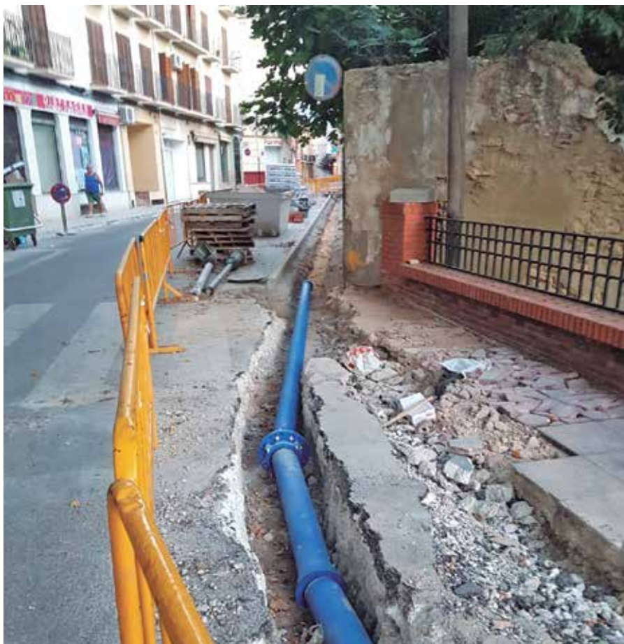
CANVI XARXA AIGUA POTABLE APROFITANT OBRES DE MILLORA
